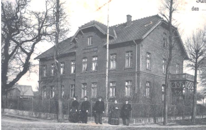
Das Burmester-Gebäude kurz nach der Erstellung
